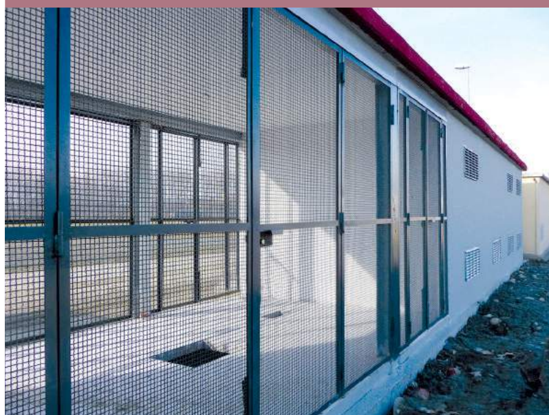
Località: Strambino (TO) Tipo di impianto: fotovoltaico Potenza: 2,5 MWp Entrato in esercizio: dicembre 2010
