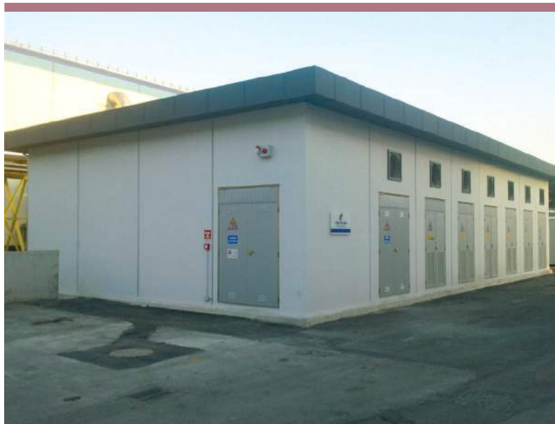
Località: Nola (NA) Tipo di impianto: Cabina di trasformazione Potenza: 6 MVA Entrata in esercizio: giugno 2013
