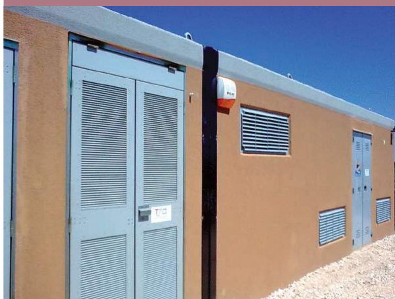
Località: Subbiano (AR) Tipo di impianto: fotovoltaico Potenza: 1 MWp Entrato in esercizio: gennaio 2011
