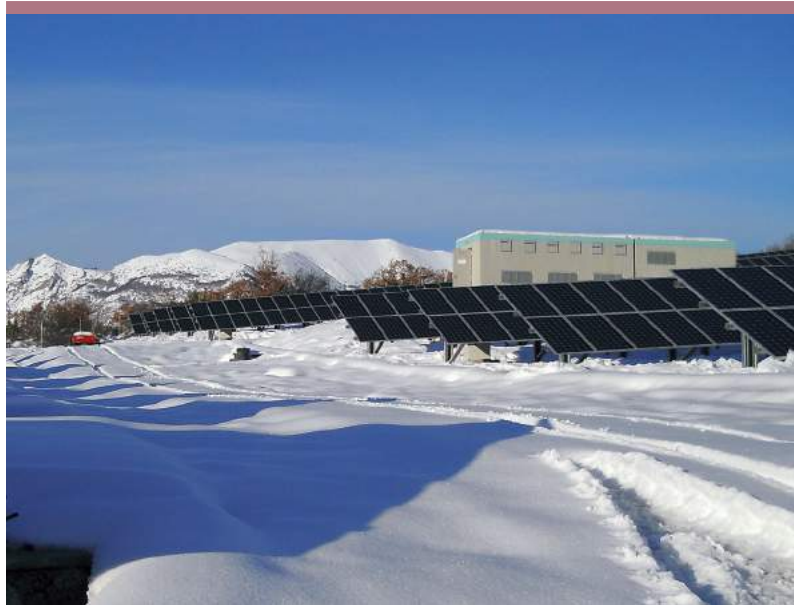
Località: Carpineto Sinello (CH) Tipo di impianto: fotovoltaico Potenza: 1 MWp Entrato in esercizio: febbraio 2011
