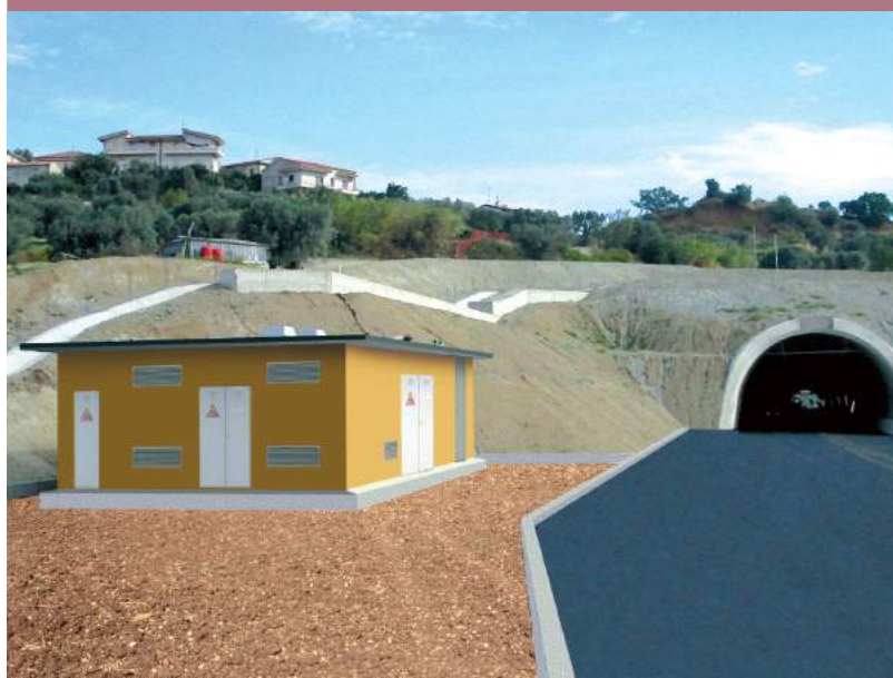
Località: Reggio Calabria Tipo di impianto: Cabina di trasformazione a servizio di gallerie e strade statali Potenza: 800 kVA Entrata in esercizio: agosto 2013
